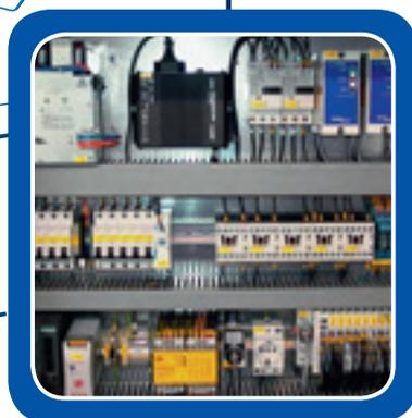
El armario de distribución PLC montado en el generador de vapor se encarga de la regulación y el control de procesos del generador de vapor.
