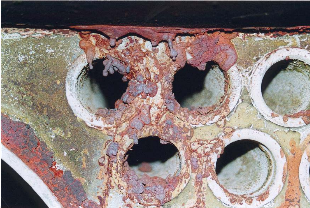
Fotografía (nº 2). Suciedad en el circuito de gases de una caldera.
