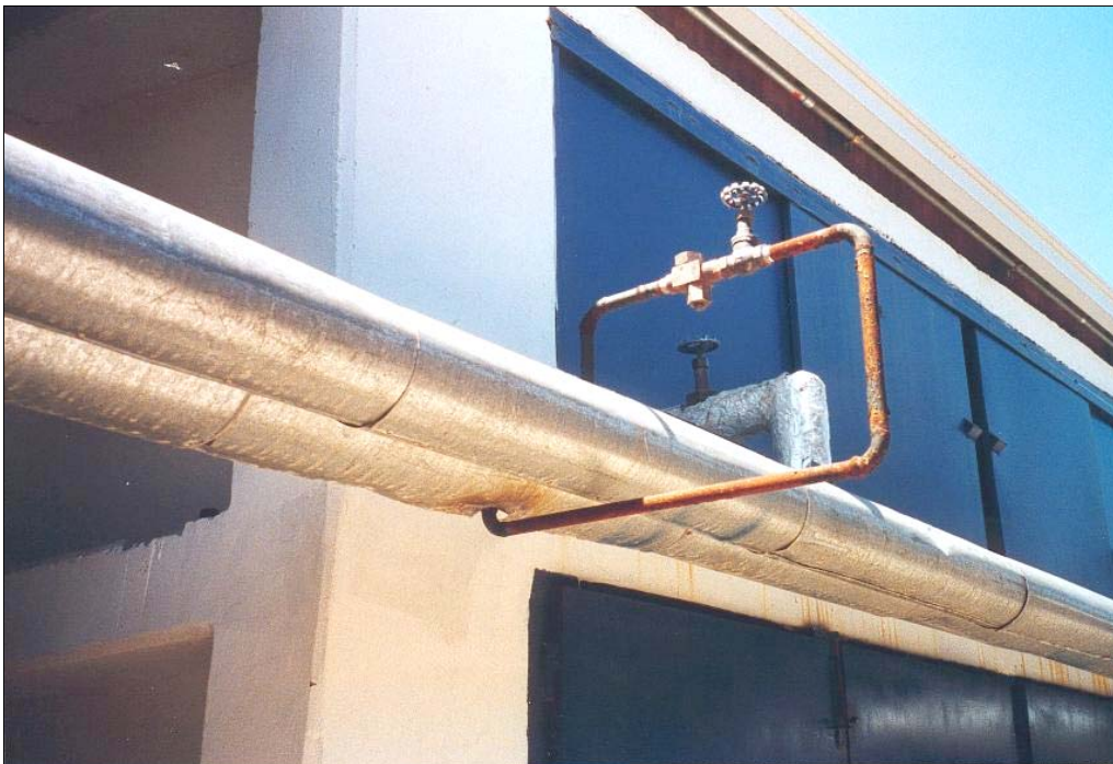
Fotografía n°3: Evacuación de condensado en línea de vapor sin buzón recolector.
