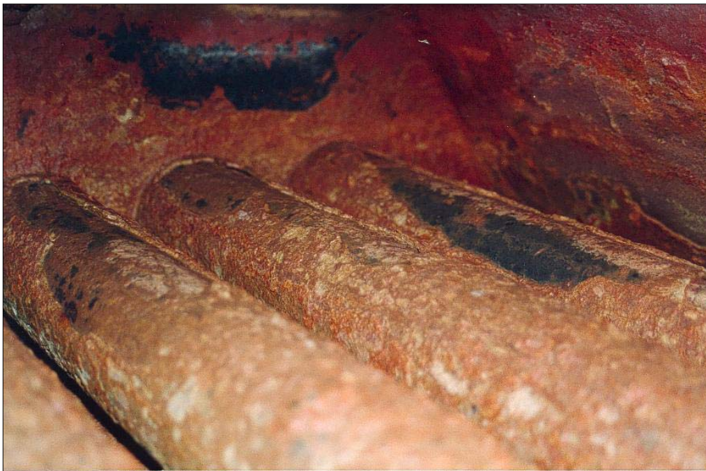
Fotografía n°1: Incrustaciones en lado agua DE LA caldera.
