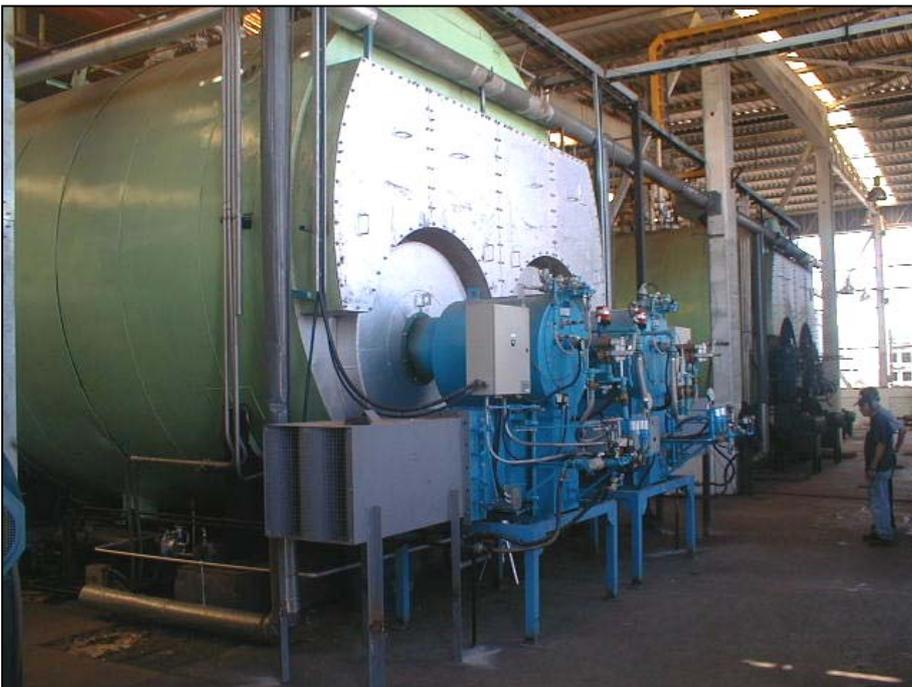
Figura n°3: Quemadores COEN Micro-NOx modelo HTE-20.
