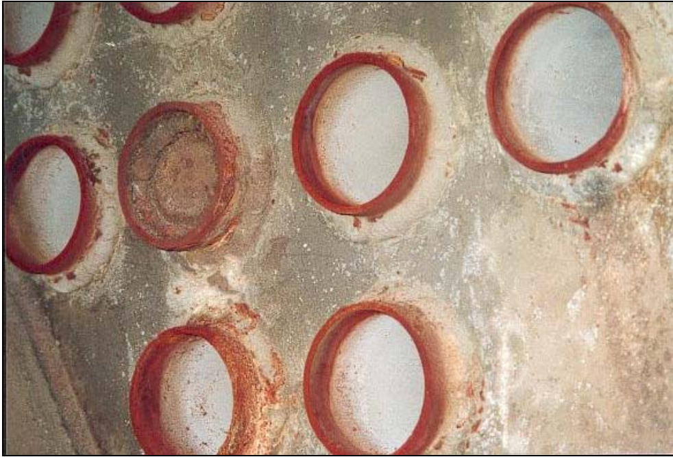
Figura nº3: Tubos sobresaliendo de la placa tubular caliente.
