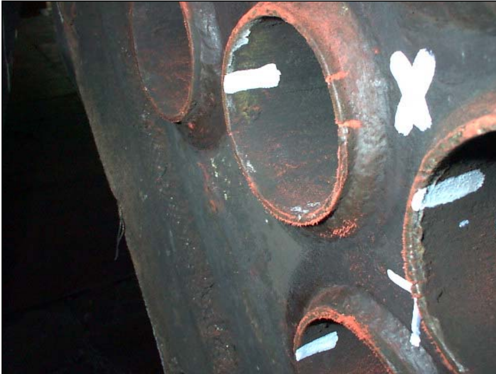
Figura n°1: Grietas en unión tubos a placa tubular (detectadas partículas magnéticas).
