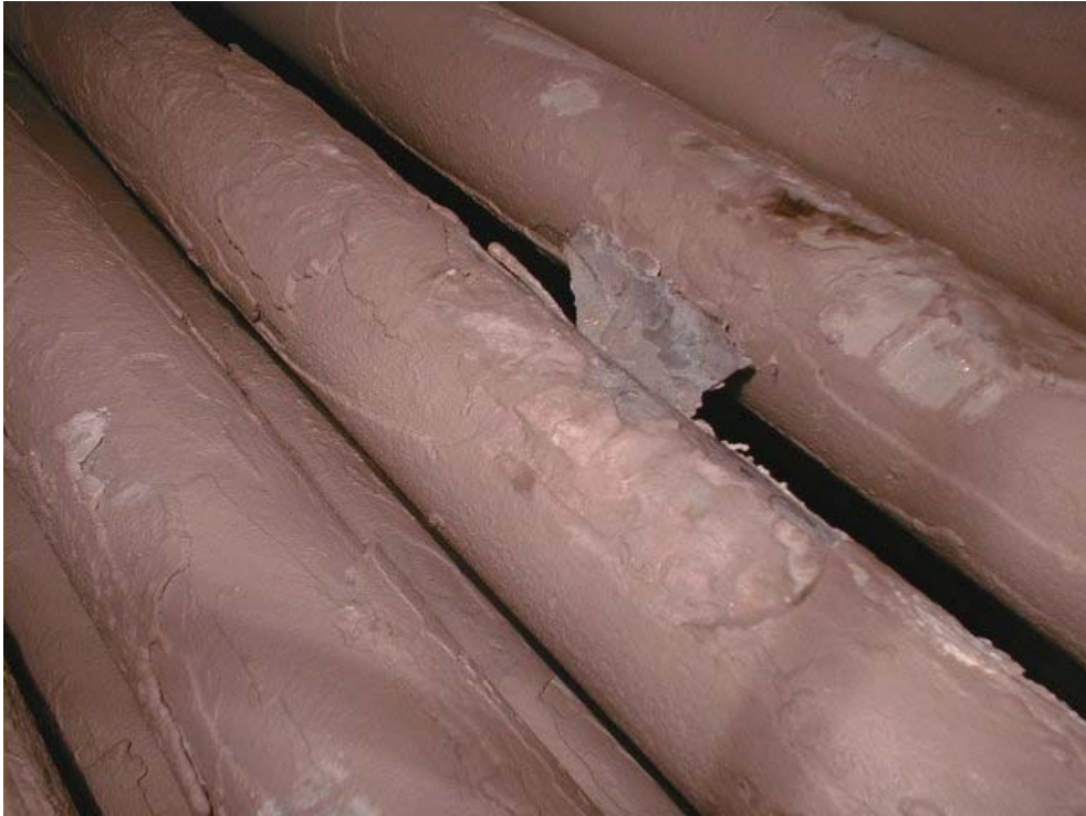
Figura n°2: Incrustaciones en el lado agua de una caldera.
