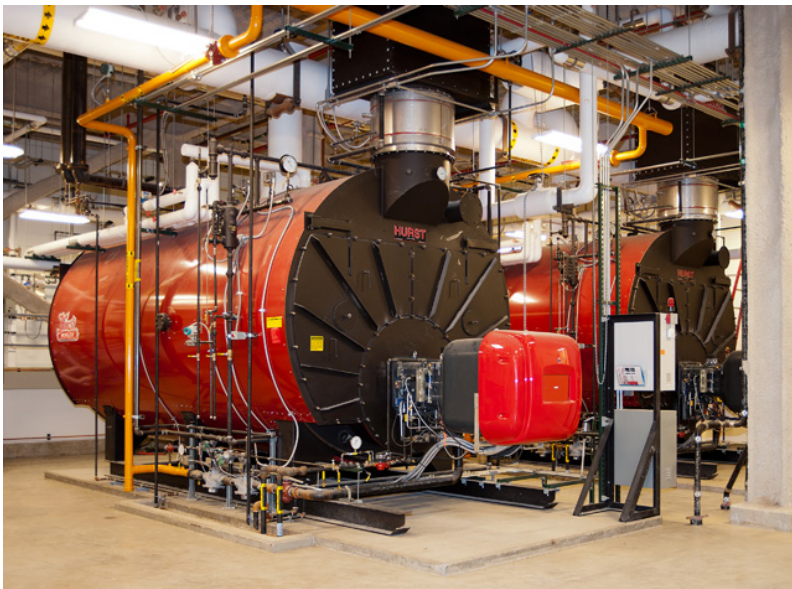
Las calderas pirotubulares tienen menor costo de adquisición e instalación.
