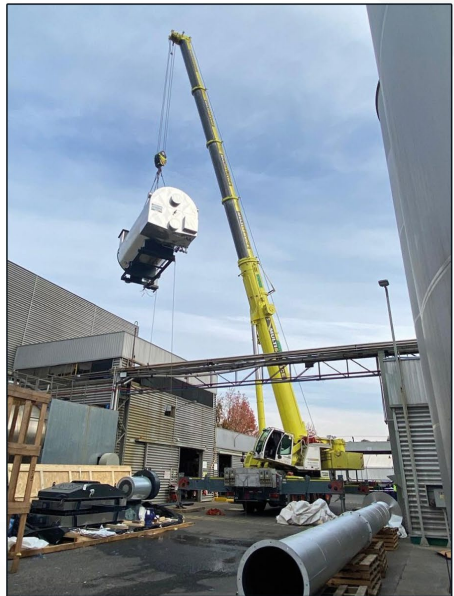
Montaje caldera 10 ton:h - Planta Vitivinícola
