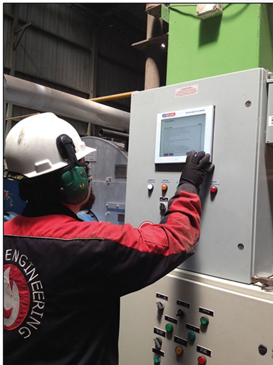
Técnico programando sistema de control
