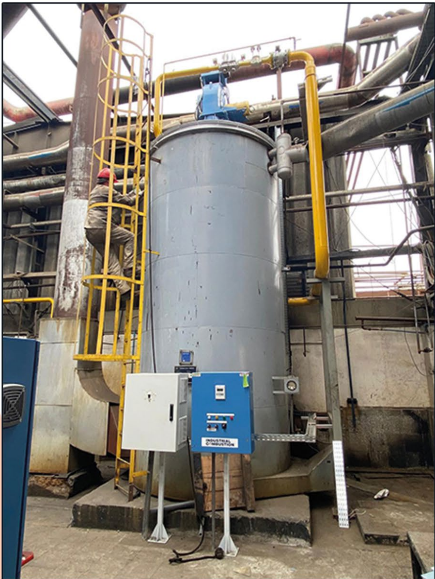
Conversión a GLP calentador aceite térmico - Pesquera
