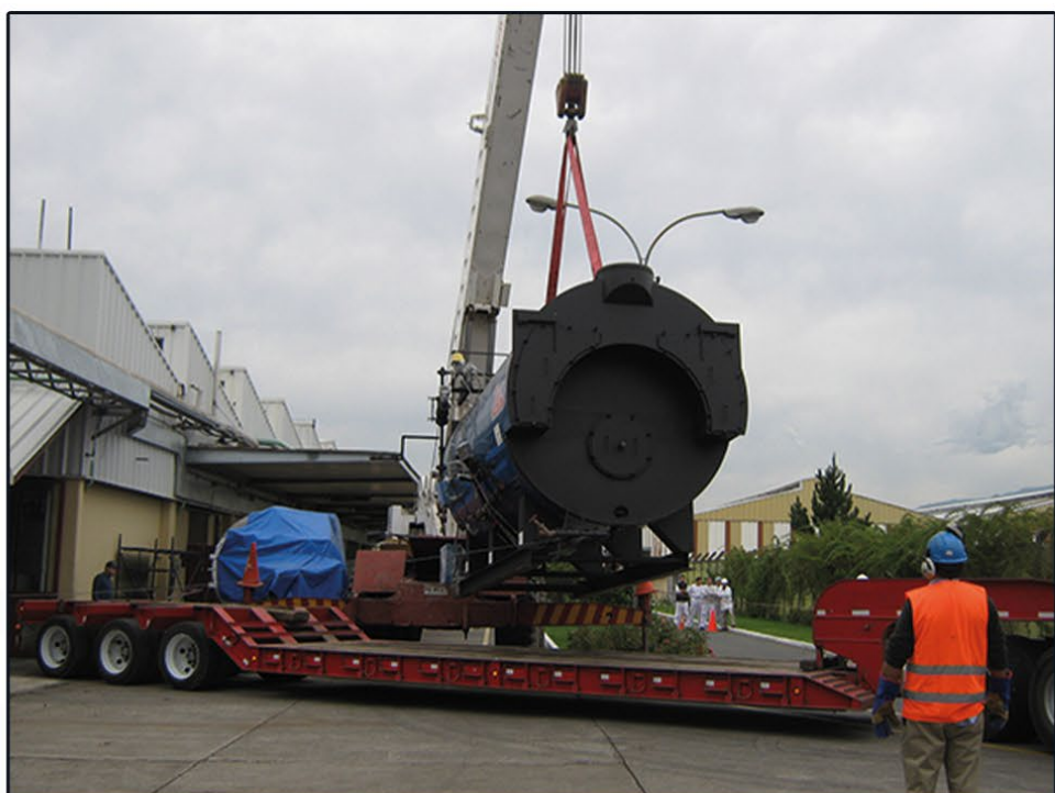
Nestlé – Montaje caldera
