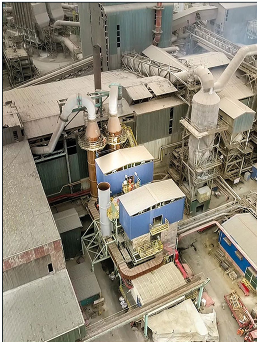
Codelco Fundición Ventanas – Control emisiones MP, y As Hornos de Refino
