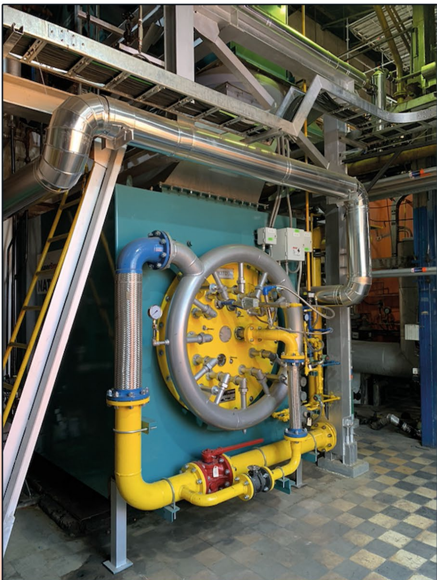
Quemador bajo NOx para caldera acuatubular 50 ton/h – Planta Papel Tissue
