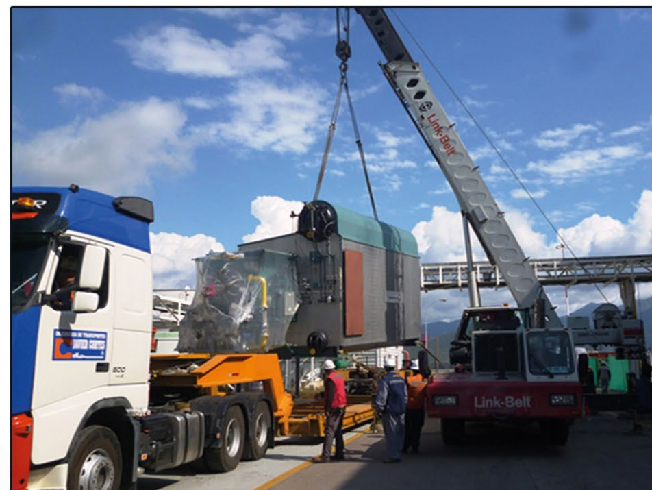
CMPC – Montaje caldera acuotubular 30 tph
