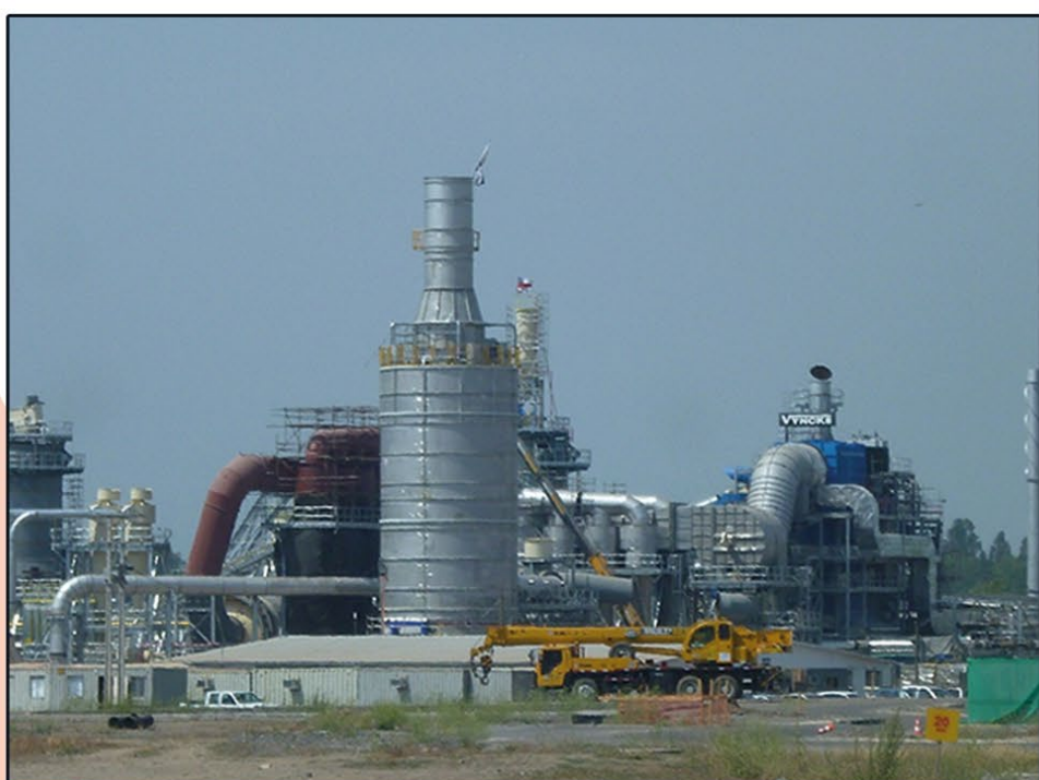
Paneles Arauco – Precipitador electrostático húmedo y ciclones
