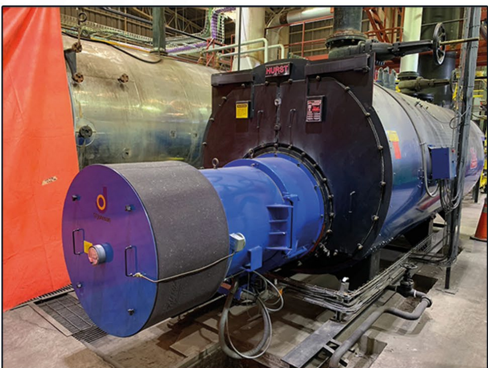
Caldera con quemador Ultra Bajo NOx
