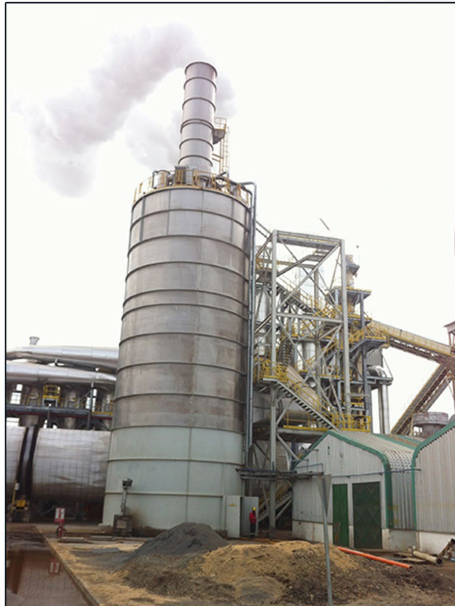
Masisa – Precipitador electrostático húmedo
