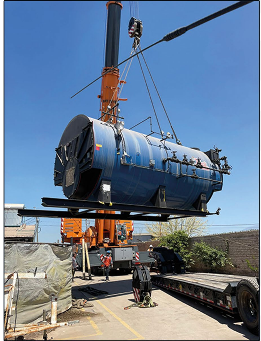
Montaje caldera - Planta salmonera
