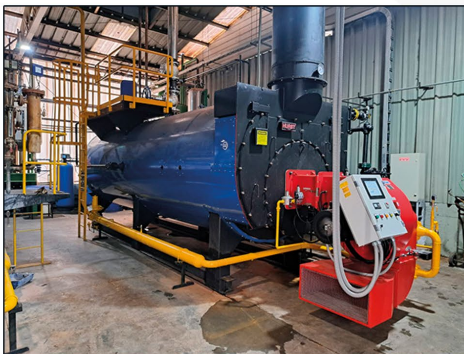
Caldera pirotubular planta de alimentos para animales
