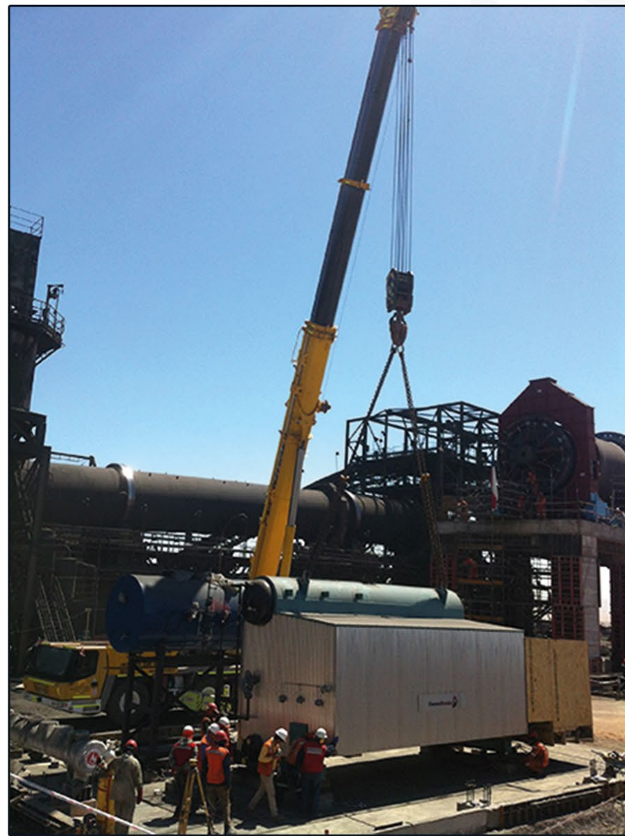
Montaje caldera 40 ton/h fundición de cobre
