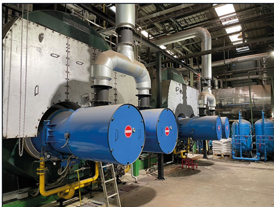
Quemadores bajo NOx – Planta de alimentos
